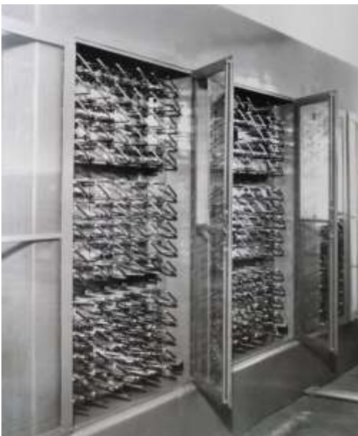
Фото 1. Шкафы «Машины ГИФТИ», хорошо видны секции и блоки.
