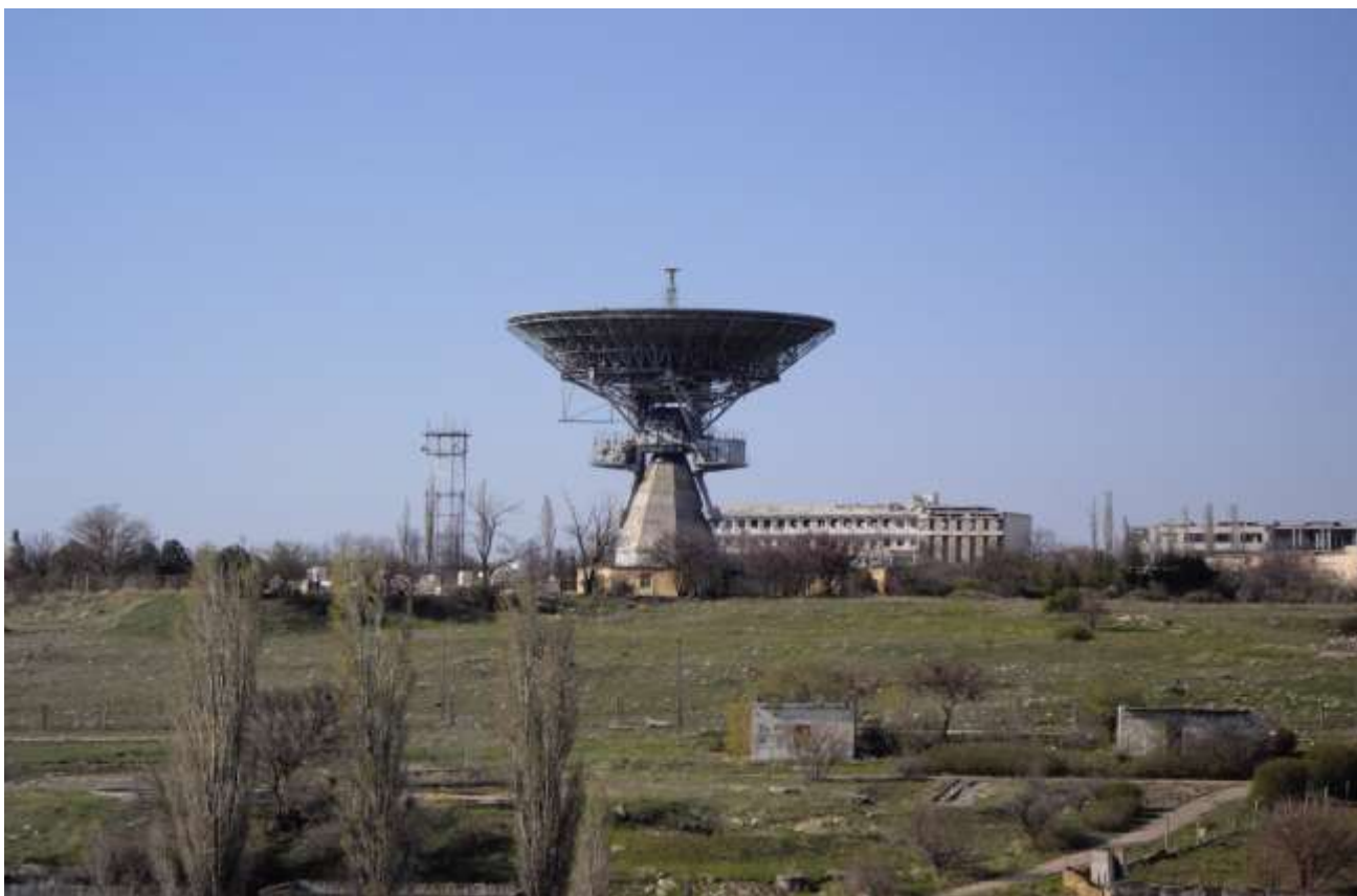
Фото 8. Антенная система ТНА – 400 с диаметром зеркала 25 метров на крымском полигоне под городом Симферополь.
