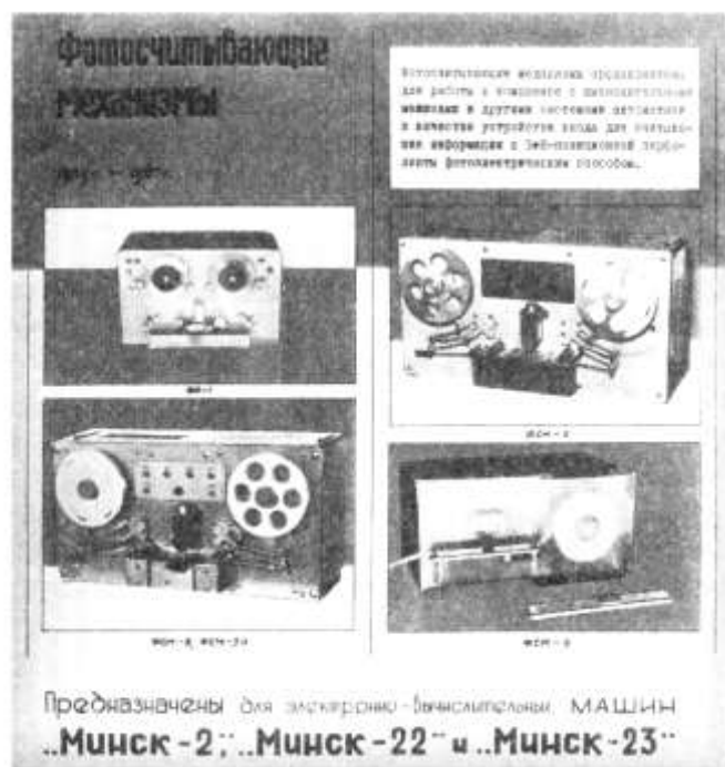
Устройства ввода с перфоленки. Фотография из альбома, посвященного 10-летию МПБ завода им. Г.К. Орджоникидзе
