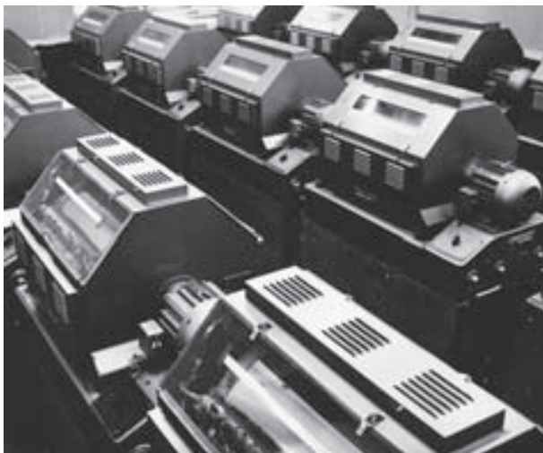
Оперативная память БЭСМ-4. Зал с памятью на магнитных барабанах
