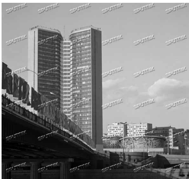
Здание СЭВ. (Мэрия Москвы, Новый Арбат, дом 36); ныне — здание Мэрии Москвы
