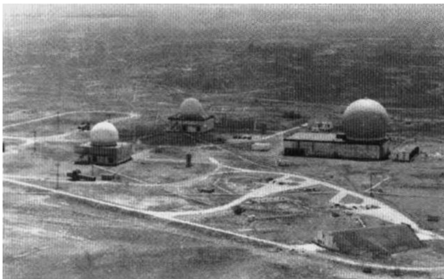
Полигонные сооружения Системы “Алдан”
