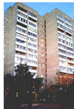
28 августа 2016 Дом по ул. Дубки. Магазина нет.
